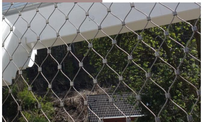
*L'orientation VERTICAL (illustration ci-dessus), dans le cas d'un garde-corps par exemple, impose un grand nombre d'œillets de fermeture de maille et augmente donc le temps de production. A éviter.*
