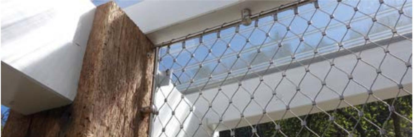
Nos filets sont réalisés **UNIQUEMENT SUR MESURES**, à partir de câbles inox de qualité Marine (Aisi316), **LIVRÉS "PRÊTS À POSER"**.
