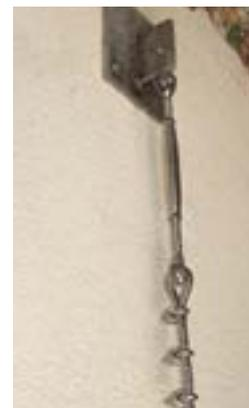
**Attention :** pour une utilisation sur câble gainé, la partie de câble recevant les serres-câbles devra être dégainée.
