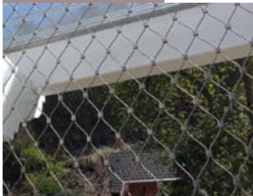
L'orientation VERTICAL (illustration ci-dessus), dans le cas d'un garde-corps par exemple, impose un grand nombre d'œillets de fermeture de maille et augmente donc le temps de production. A éviter.
